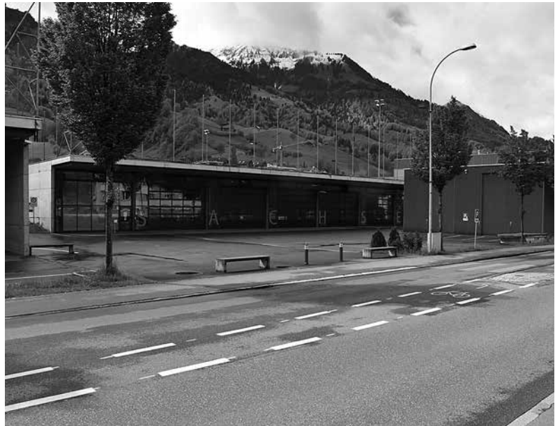
Diese Einspurhilfe soll den Schulkindern zu einem sicheren Linksabbiegen verhelfen.
