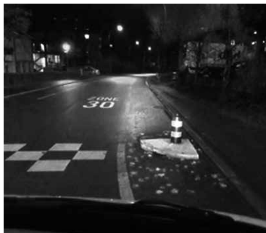
Poller auf Betonsockel ist schlecht sichtbar.
