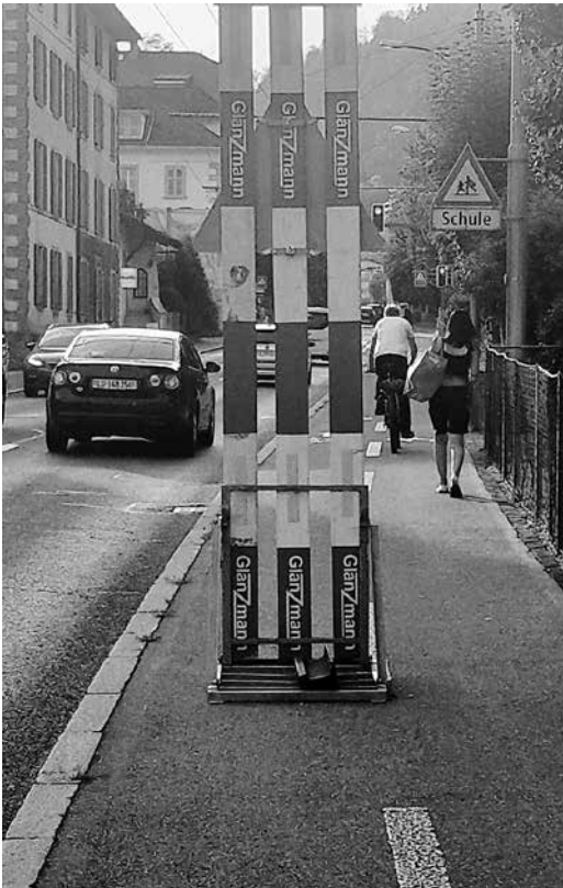
Das Velowegnetz in der Agglomeration ist eine grosse Baustelle
