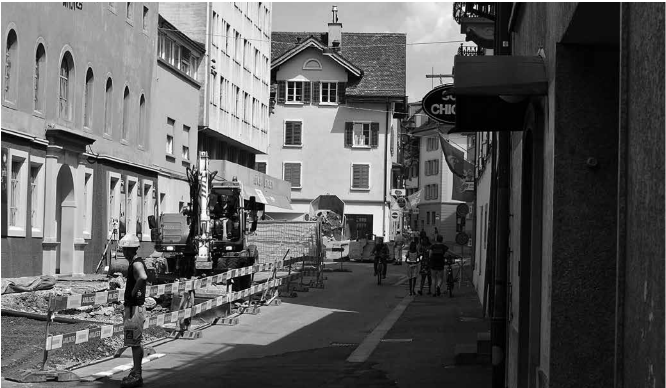
Baustelle im Löwengraben
